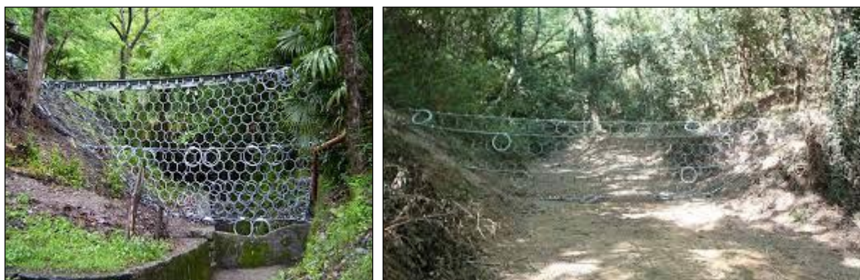
Figura 18 – Esempi di installazione di reti debris flow in ambito montano analoghe a quelle previste.
