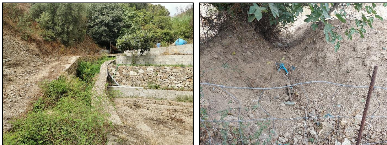
Figura 4 – A sinistra l'alveo del rio Funtana Manna con canale "ad U" rivestito in malta e pietrame e folta vegetazione arbustiva, a destra sezione naturale appena a monte del pozzetto di imbocco del rio Funata Essi.
