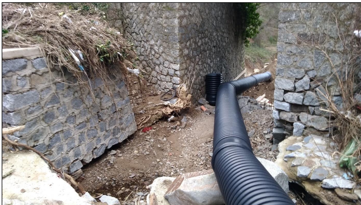
Figura 26 – Immagine esemplificativa di tubazione provvisoria per lavorare "in asciutta" in alveo.
