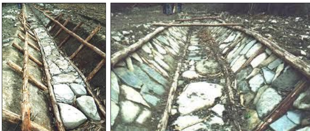
Figura 22 - Immagine esemplificativa di canale in legname e pietrame in realizzazione e ad opere ultimata.
