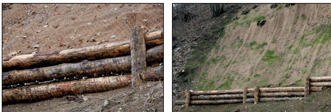
Figura 21 – Immagine esemplificativa di palizzate in legname realizzate ed in fase di rinverdimento.
