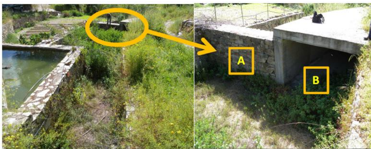
Figura 15 – Imbocco del canale diversivo (B) del rio Funtana Manna la cui testata è presidiata dal muro (A).
